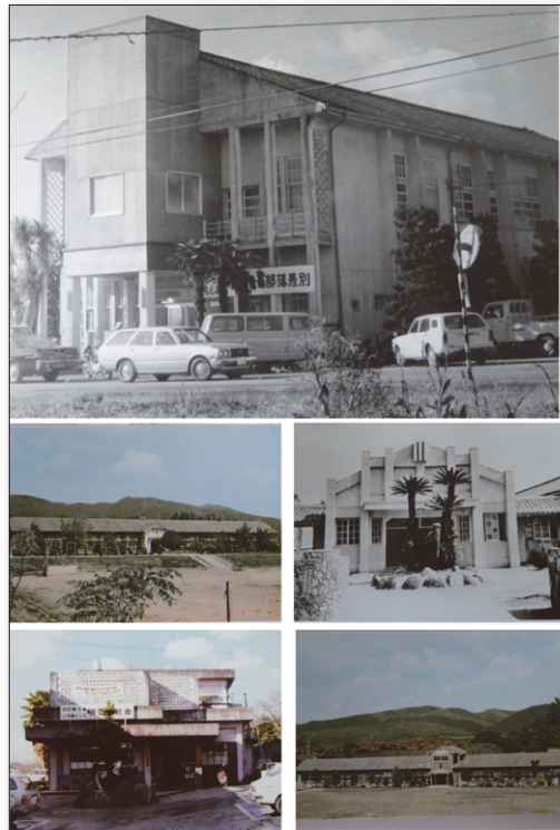
※上：上板町役場(旧庁舎)、中左：旧松島中学校、中右：旧大山中学校、下左：旧上板町公民館、下右：旧高志中学校
