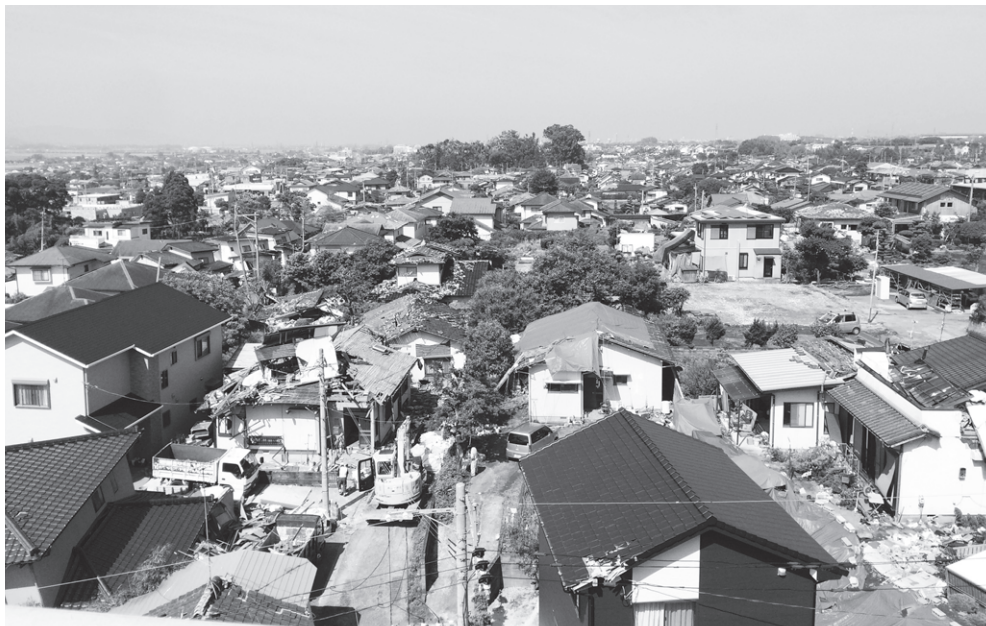
益城町役場周辺の被害
