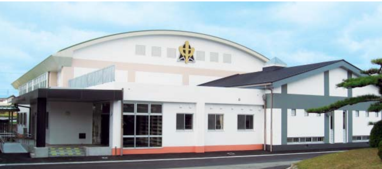
新体育館は、中央にアリーナ、武道場と更衣室が 2 室、部室が 2 室、管理室、準備室を設え従来より 1.8 倍の面積
